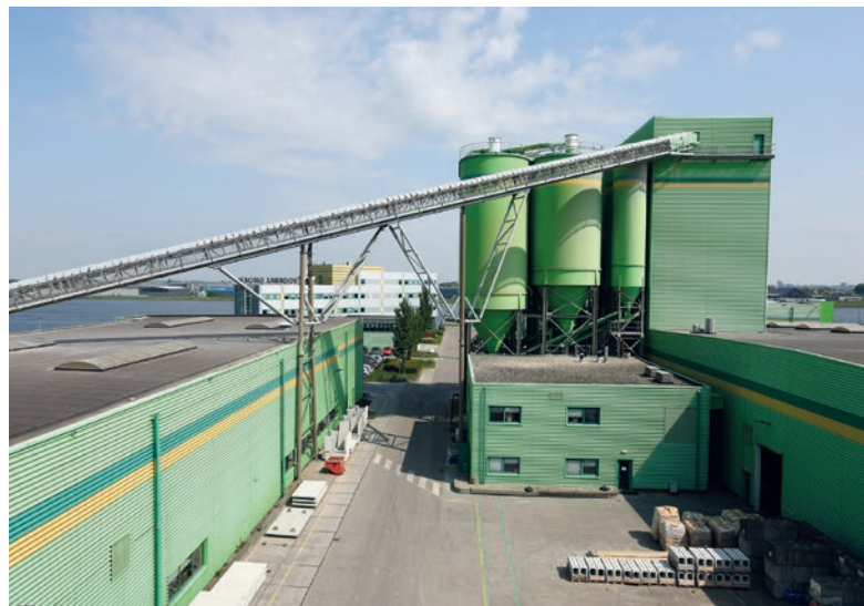
En Voorbij Prefab, la sostenibilidad y la calidad van de la mano: el hormigón normal ya cumple los objetivos de CO 2 estipulados para el año 2030, mientras que «Impakt Beton» ya alcanza actualmente los niveles de 2050
