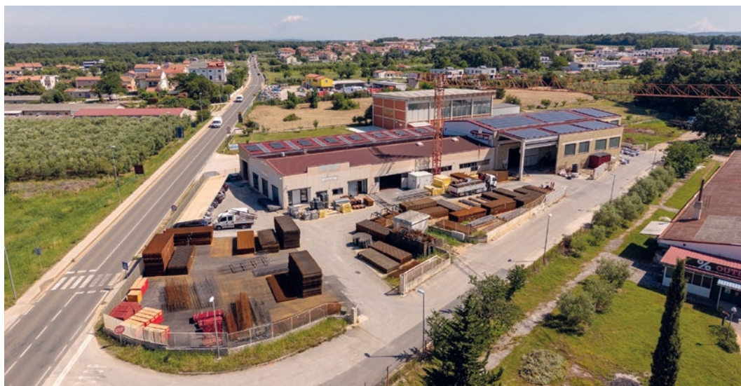
Zakład firmy Sternafer w Novigradzie w Chorwacji.
