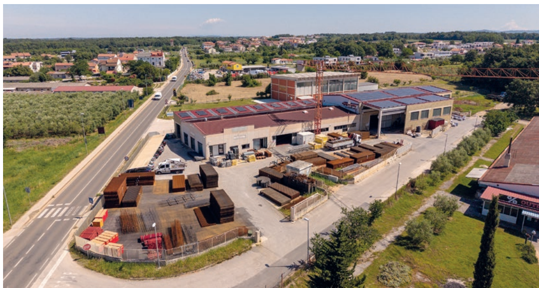
L'usine de Sternafer à Novigrad, en Croatie.
