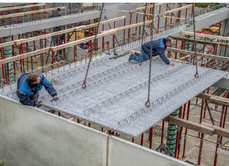
A Jungwirth produz lajes pré-moldadas e também paredes duplas, com e sem isolamento, na fábrica moderna com linha de produção tipo carrossel da Ebawe Anlagentechnik.
