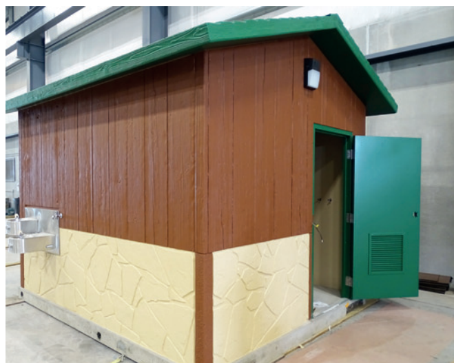
Firma Huffcutt produkuje budynki sanitarne z masywnych elementów betonowych i składa je bezpośrednio w zakładzie, wyposażając je we wszystkie wymagane urządzenia sanitarne. Te niewielkie budynki mają wykończenie architektoniczne uzyskane za pomocą betonu barwionego w masie oraz matryc odwzorowujących płytki, kamień naturalny lub drewno.
