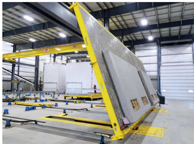
Elementy ściennne są podnoszone do pionu za pomocą stołu uchylnego, dzięki czemu mogą być wygodnie zdejmowane i składowane w pozycji wbudowania.
